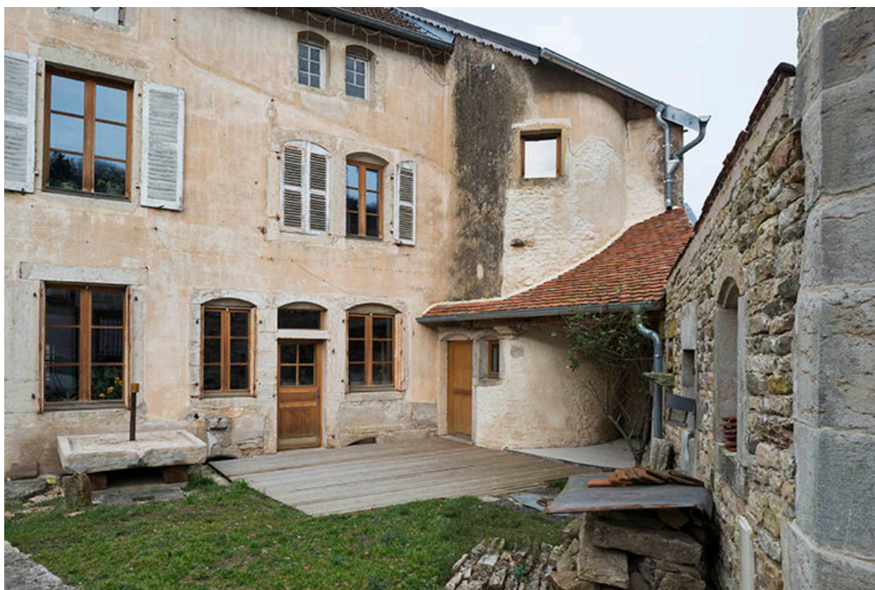
La tour d'escalier, vue extérieure.
