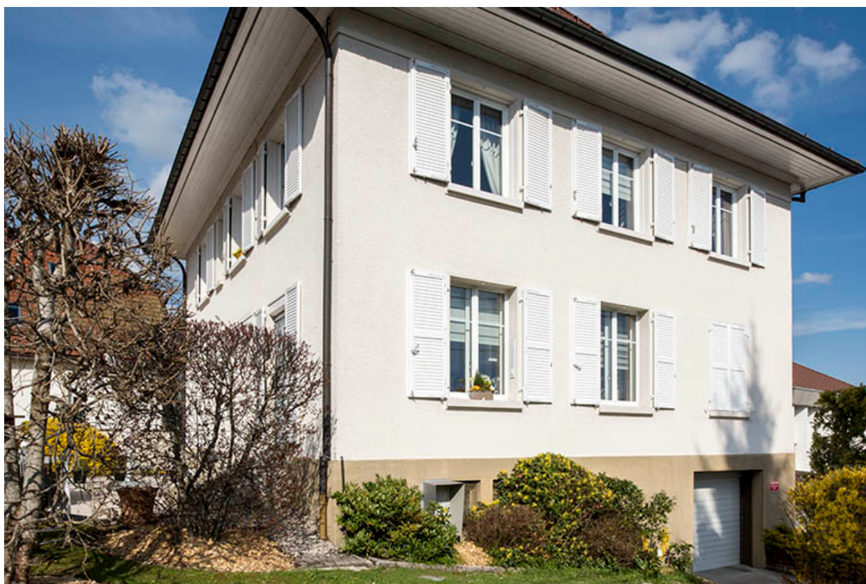
Maison-usine : élévation sud-ouest.
