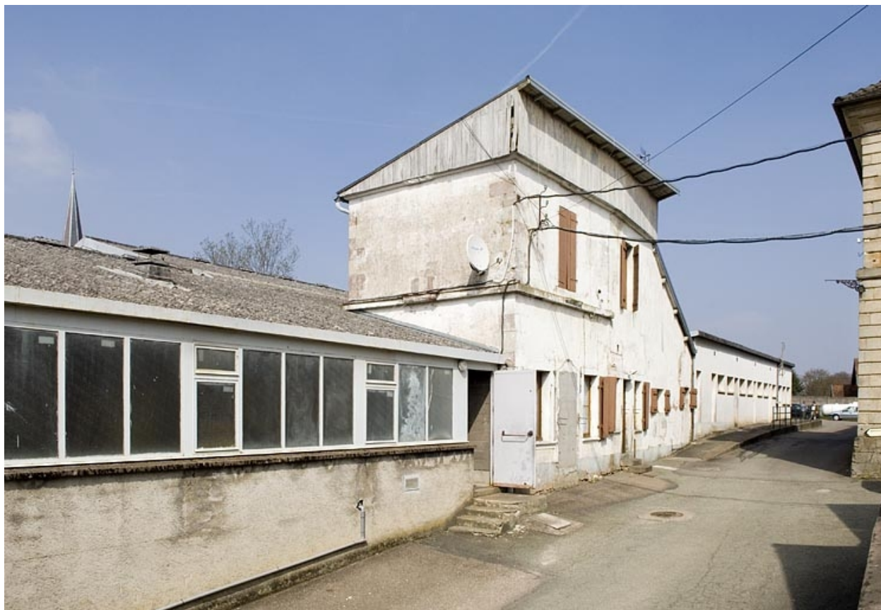
Atelier et logement.
