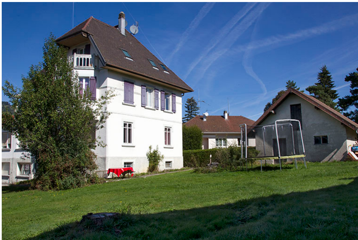
Maison (façade latérale droite) et garage.
