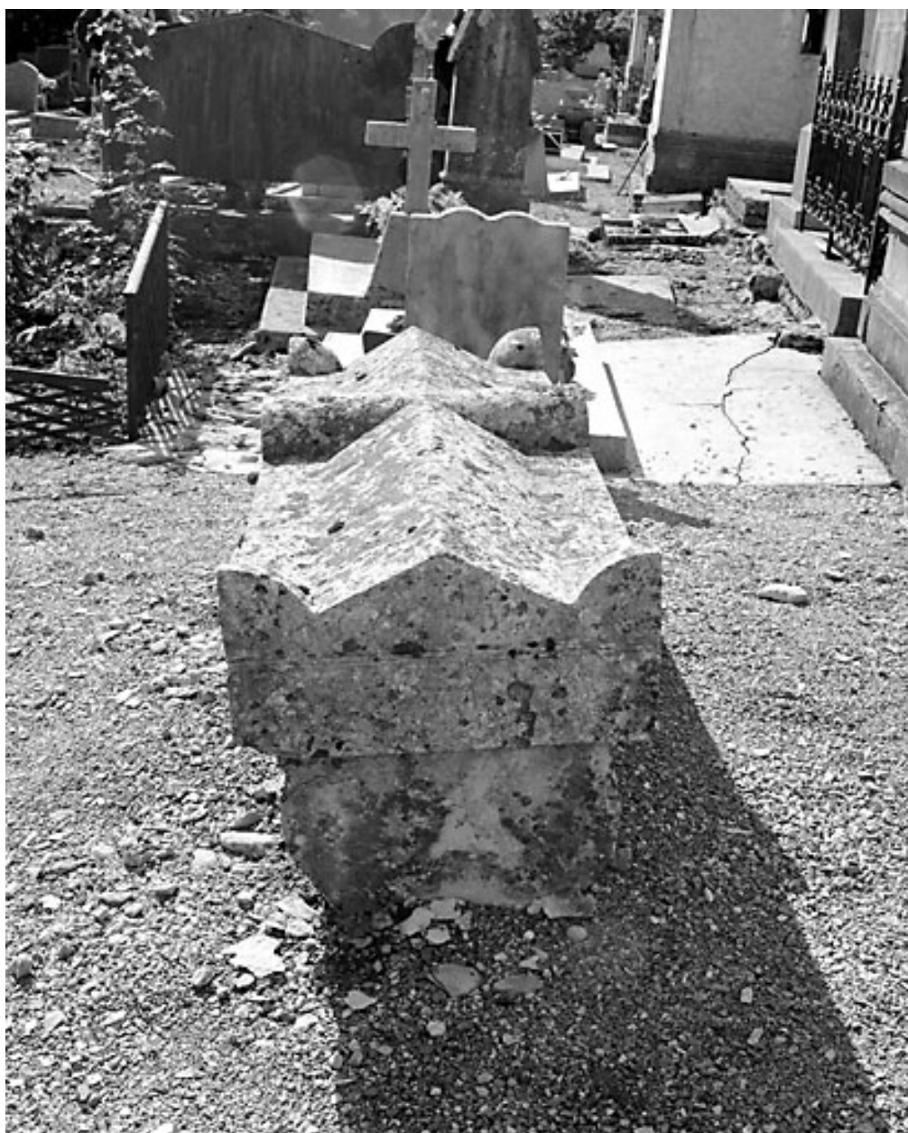
Vue dans l'axe longitudinal.
