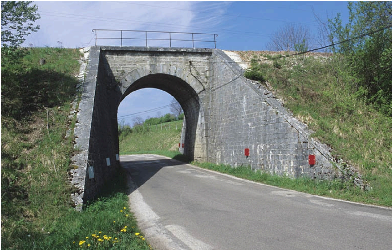
Pont sur la route départementale n° 27 : vue d'ensemble, depuis l'est.
