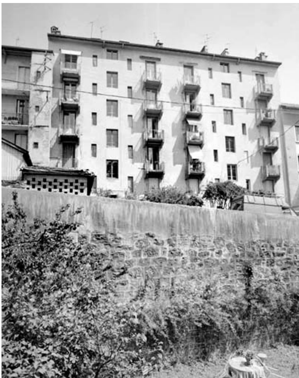
Façade postérieure de l'immeuble aux 15-17, rue Lançon.
