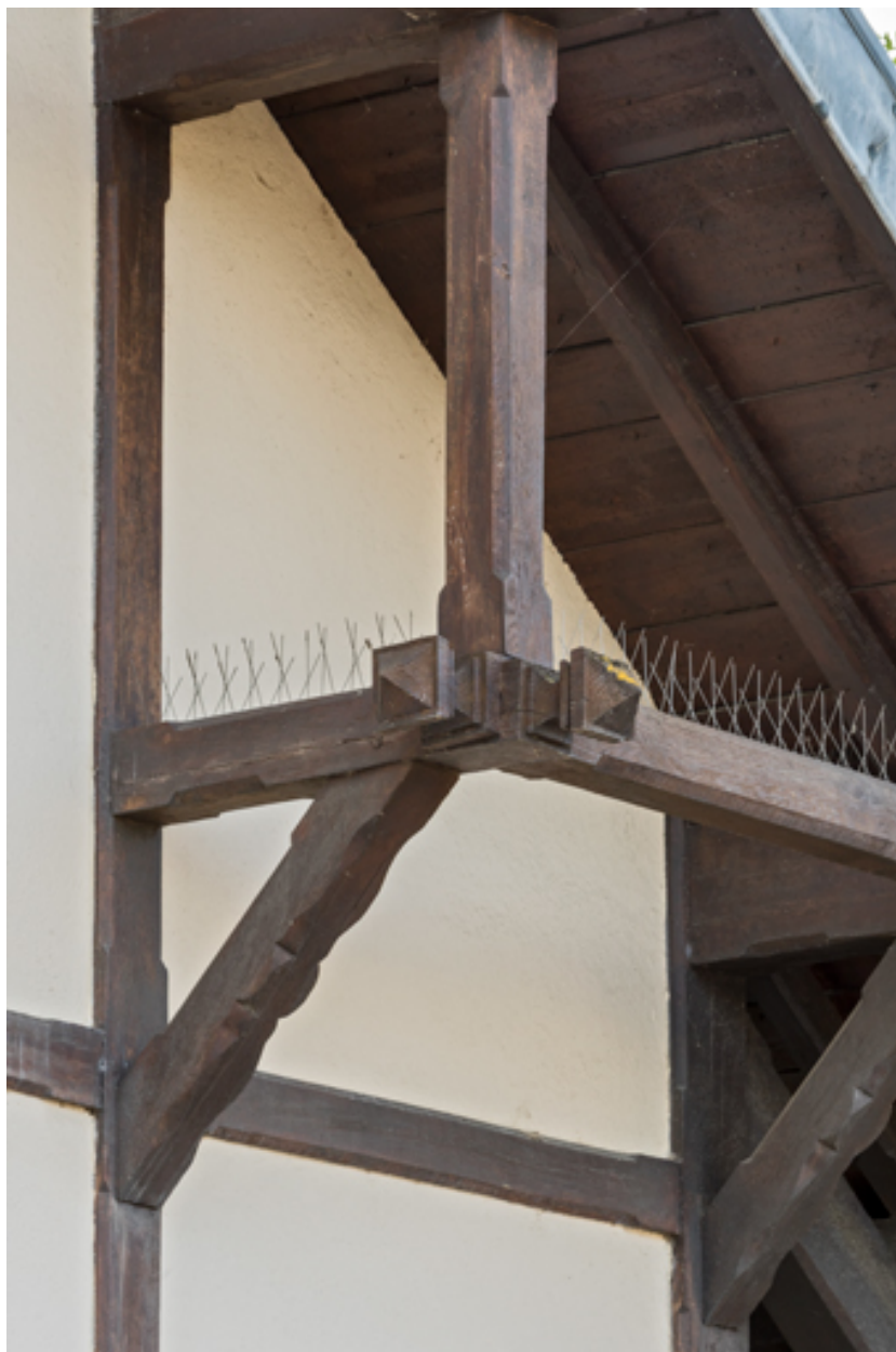
Détail de la charpente en bois.
