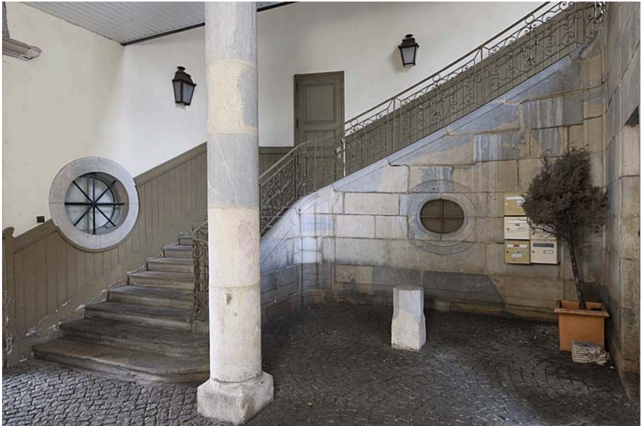
Hôtel : vue d'ensemble de l'escalier d'honneur, de trois quarts droit.
