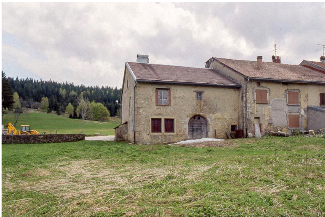
Vue éloignée de la façade postérieure.
