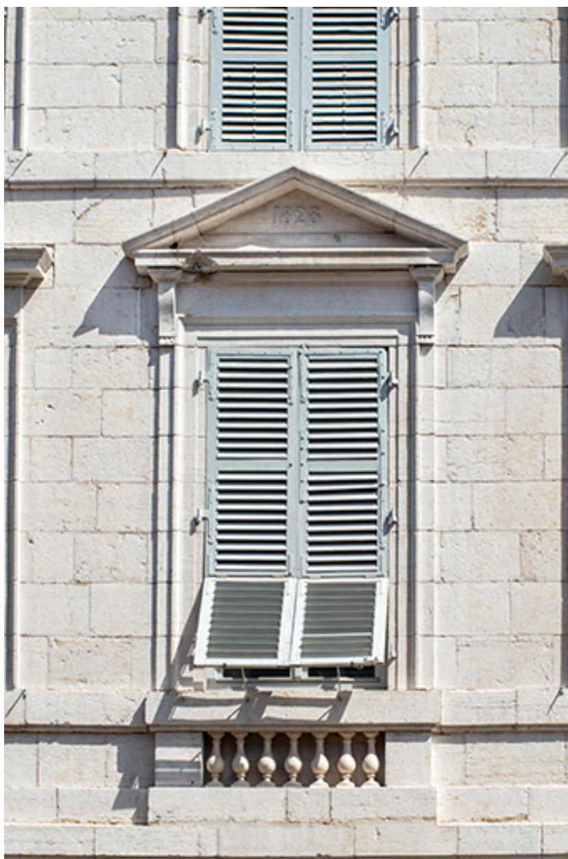
Fenêtre centrale du premier étage.
