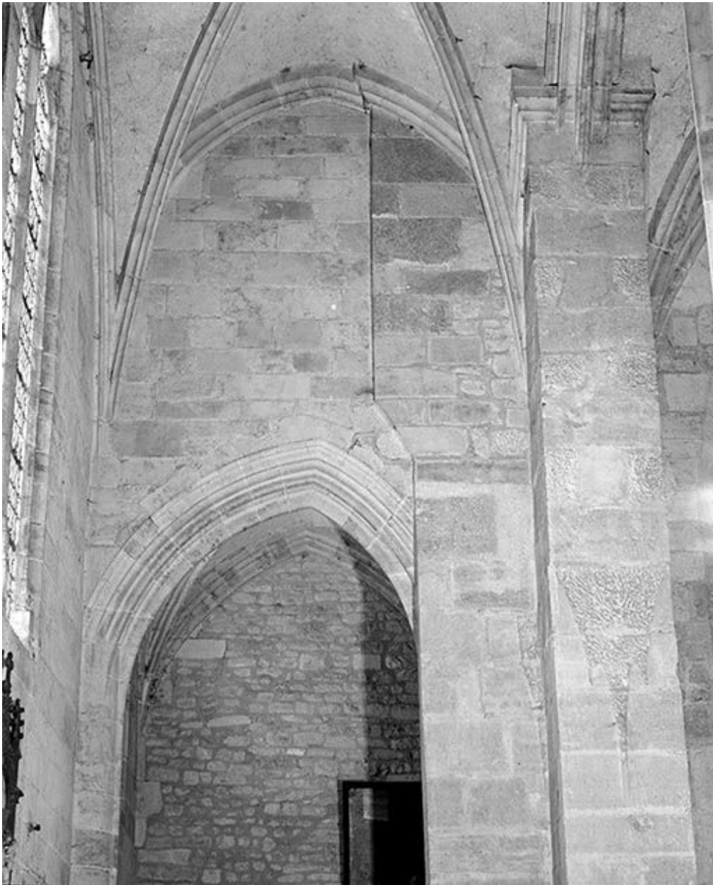
Collatéral droit, 1ère travée, arc-diaphragme antérieur ouvrant sur la chapelle des fonts baptismaux.
