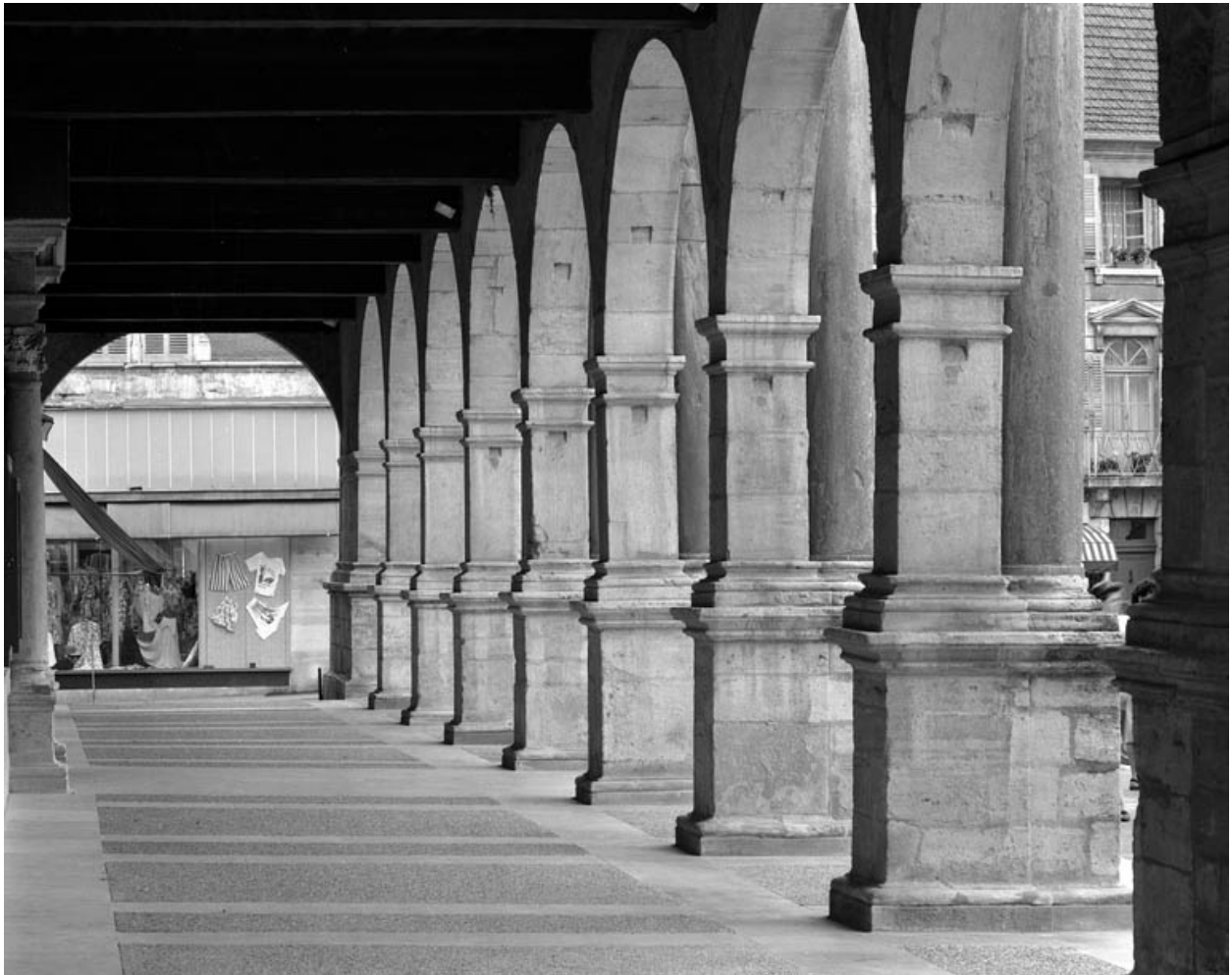
Vue du portique depuis son extrémité droite.
