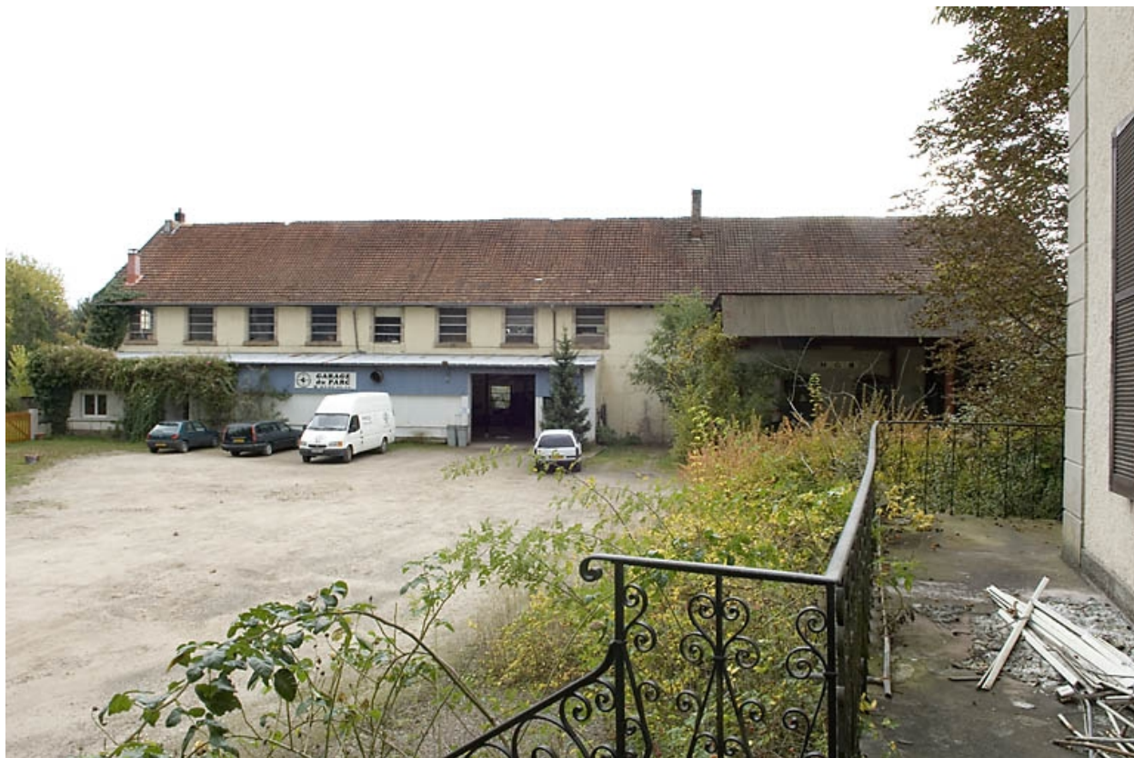
Atelier de fabrication. Vue depuis le nord-ouest.
