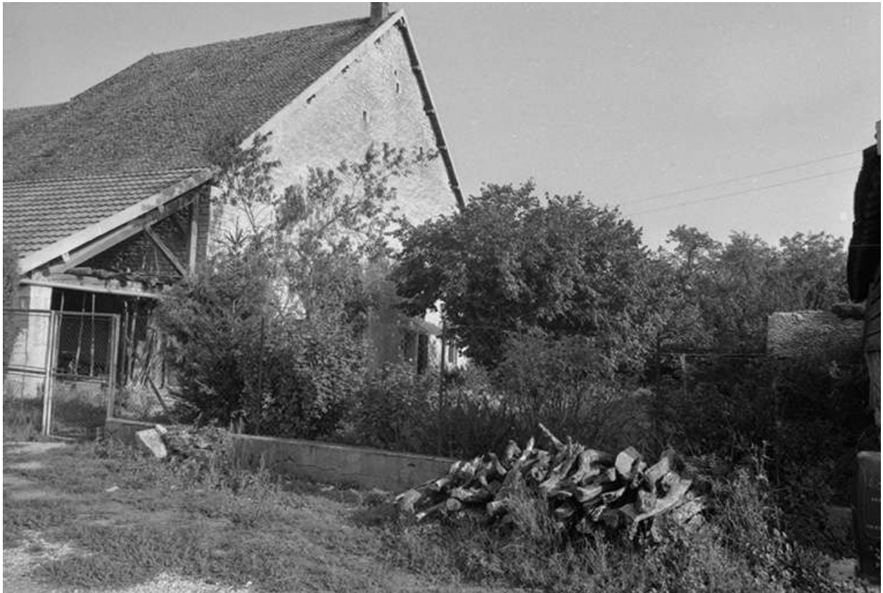
Ferme située 12 rue de Merey. La partie gauche correspondant à l'avant-toit a été détruite après 1976.
