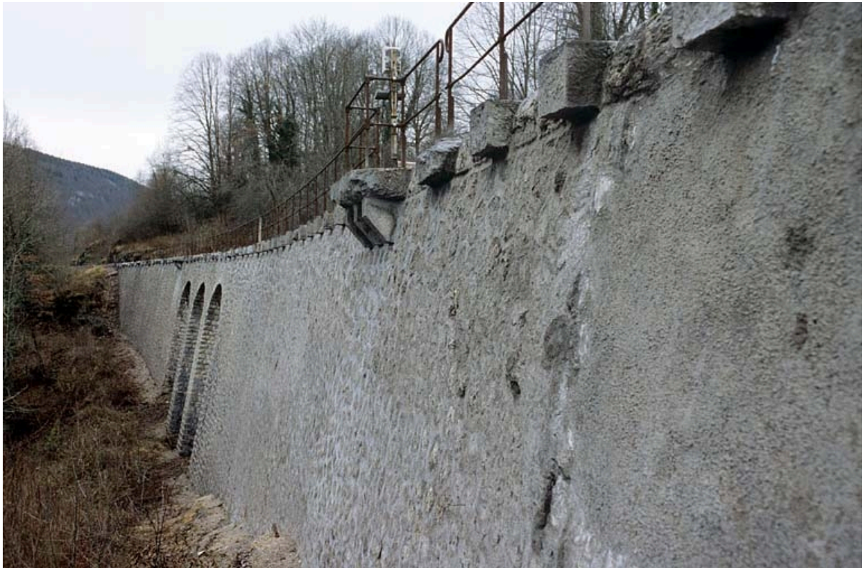
Vue d'ensemble en enfilade, depuis le côté Andelot-en-Montagne (nord)
