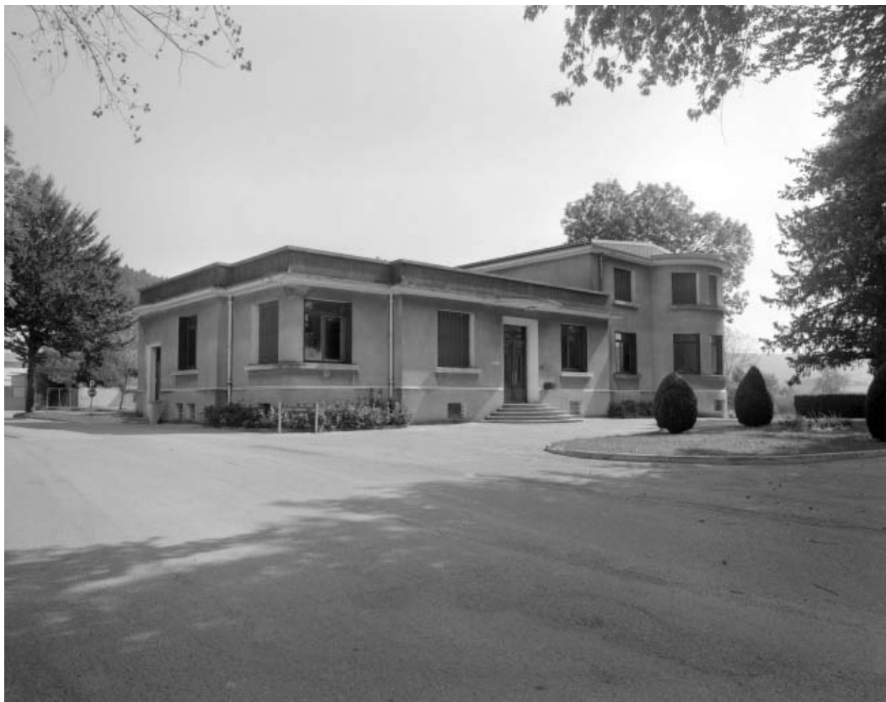
Conciergerie, bureau et logement.
