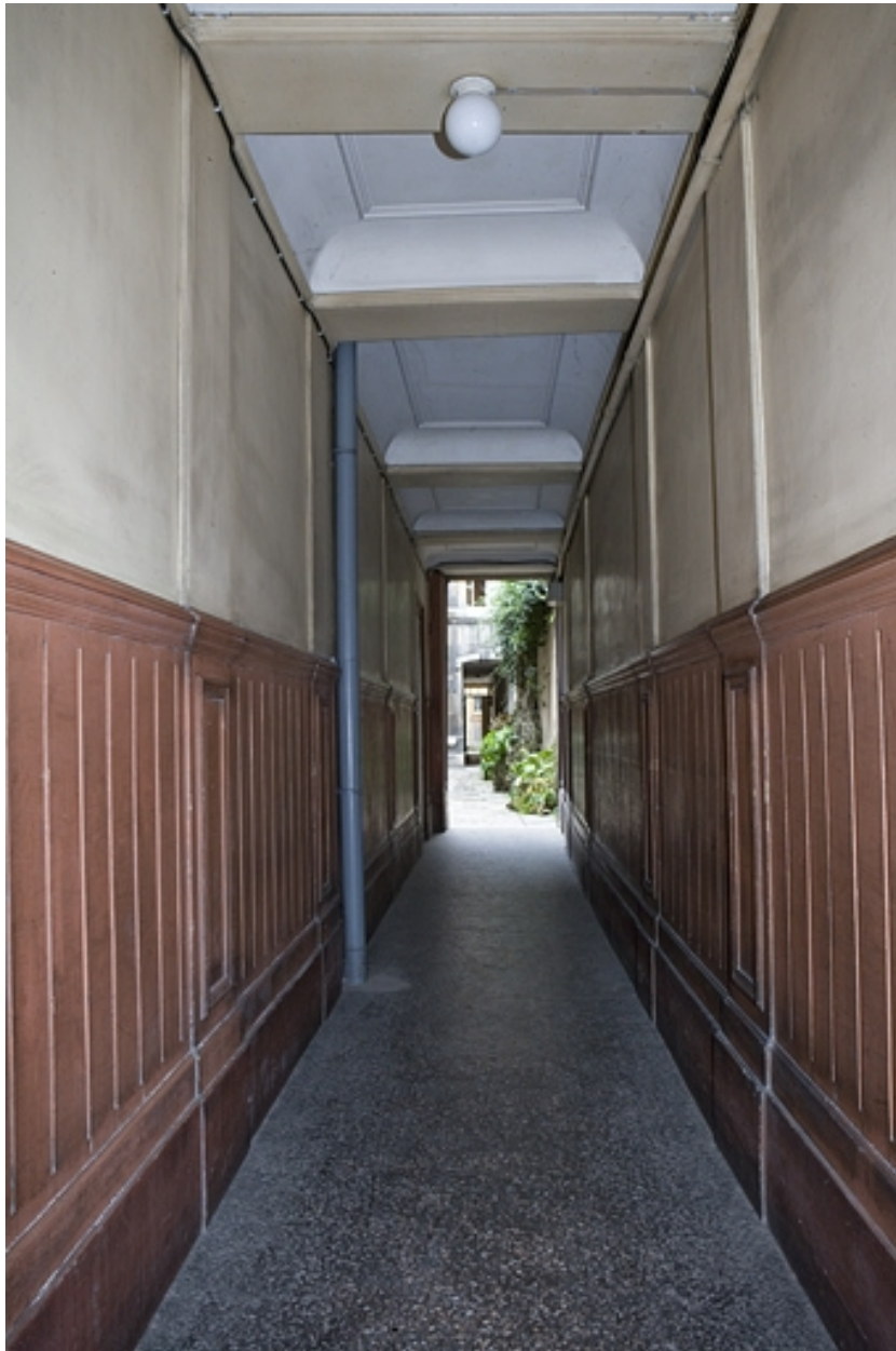
Vue d'ensemble du couloir d'entrée.
