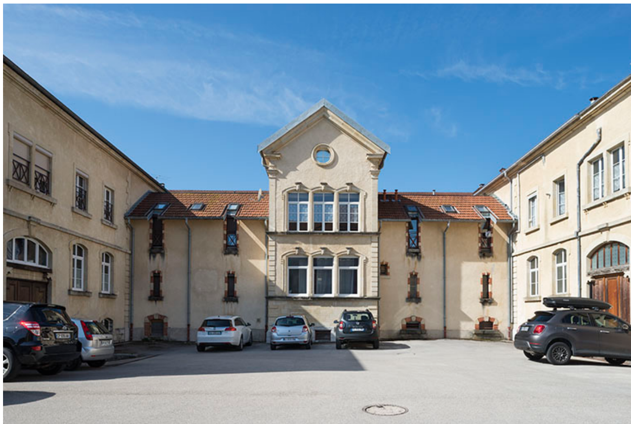
Vue axiale depuis la cour nord.
