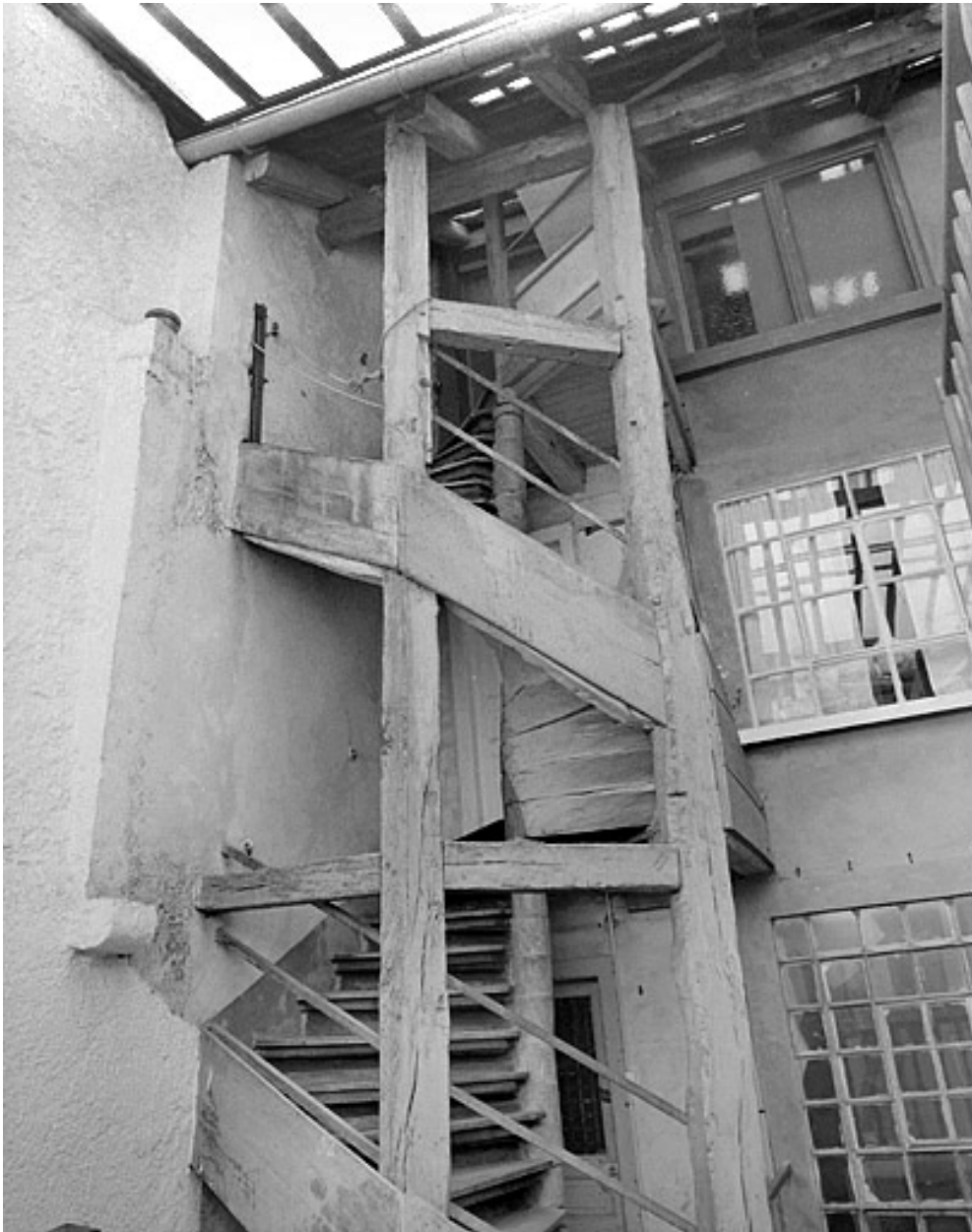
Maison 53, rue Georges-Clémenceau. Escalier. 16e ou 17e siècle.
