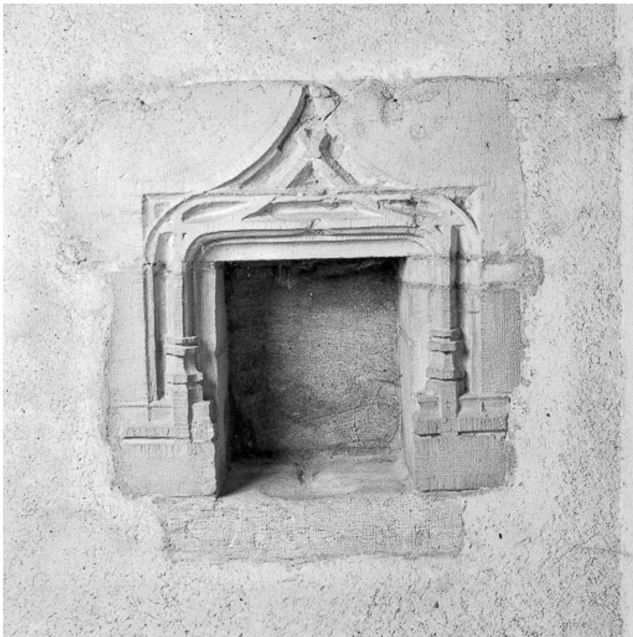
Niche dans un mur intérieur.
