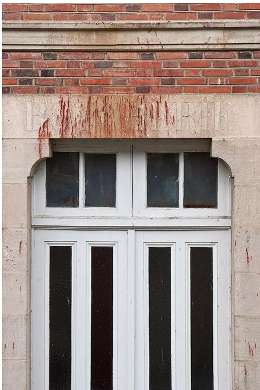
Bâtiment de services : détail.
