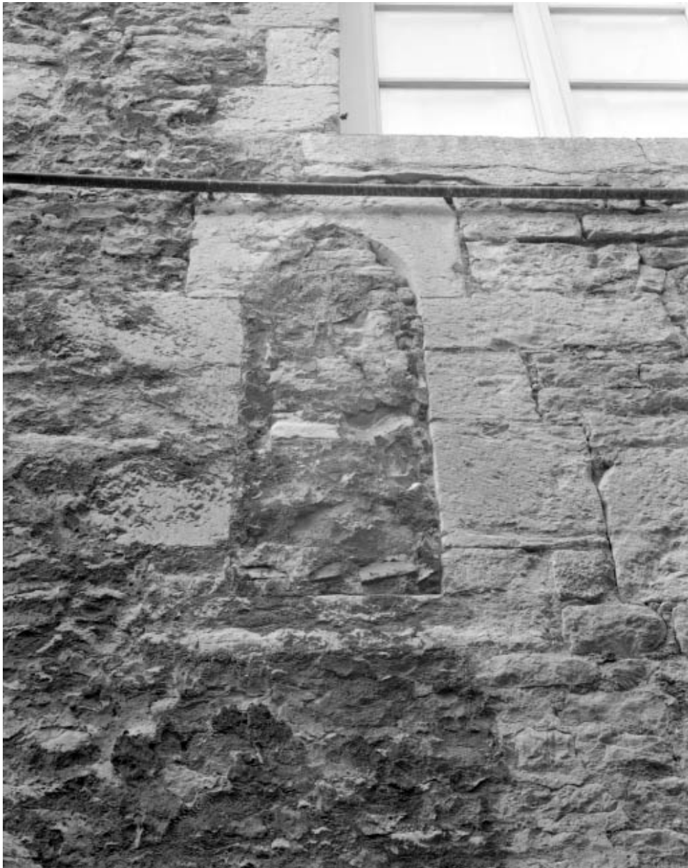
Façade latérale gauche : détail d'une baie murée.
