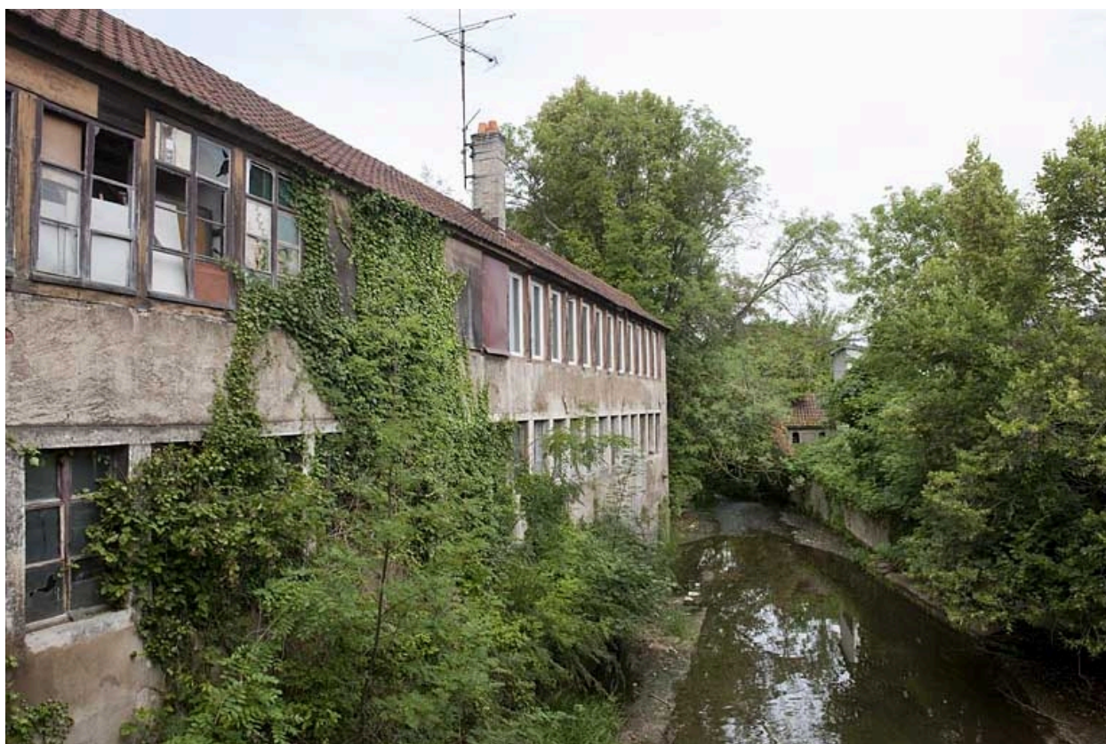
Usine Louis Boname, à Seloncourt (17 rue d'Audincourt).
