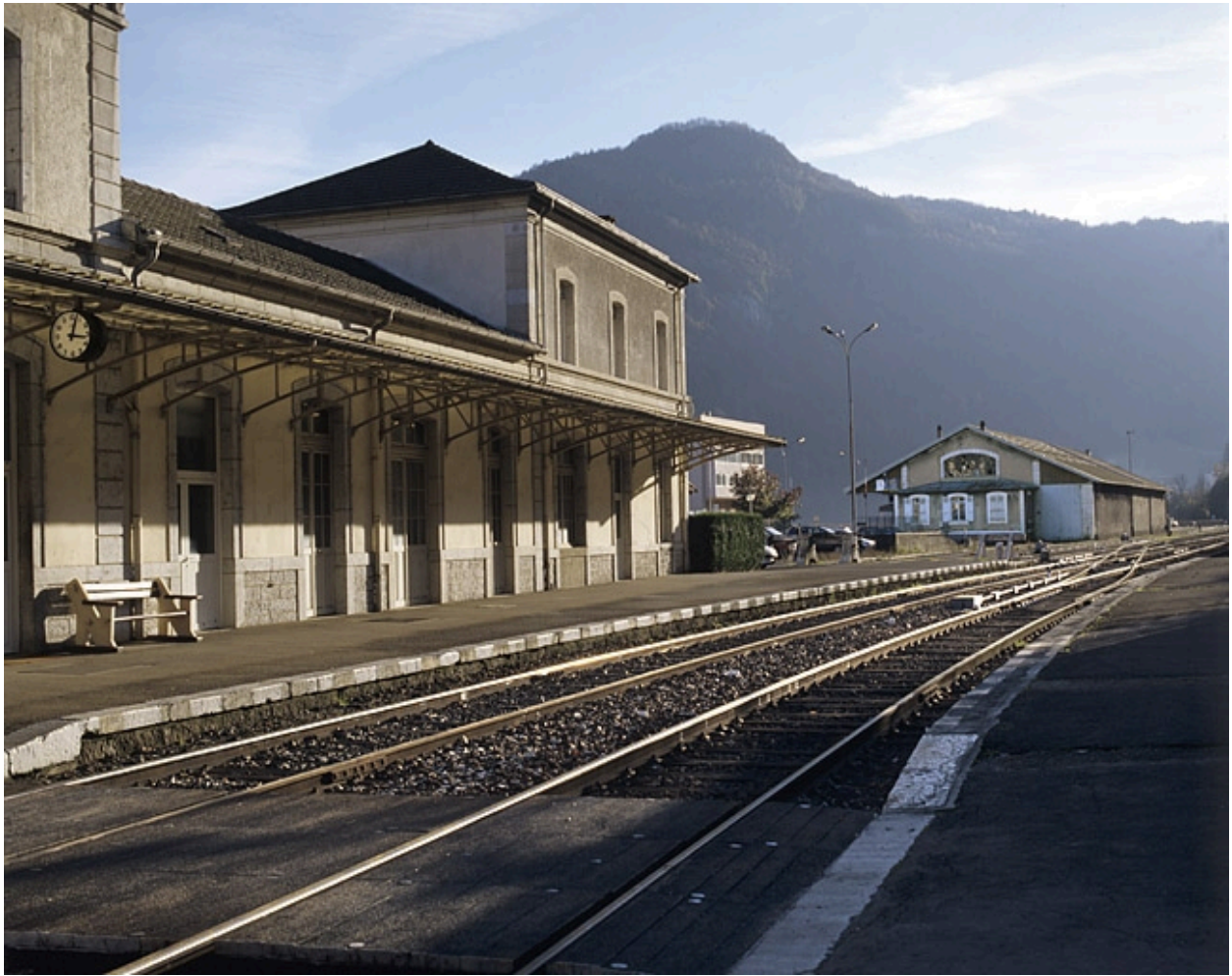
Bâtiment des voyageurs, quais et entrepôt, depuis l'abri-lampisterie.
