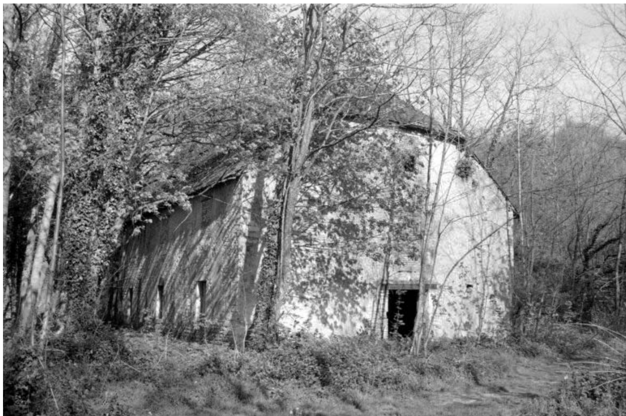
Vieille Forge. Logement d'ouvriers (B) vu de trois quarts gauche.
