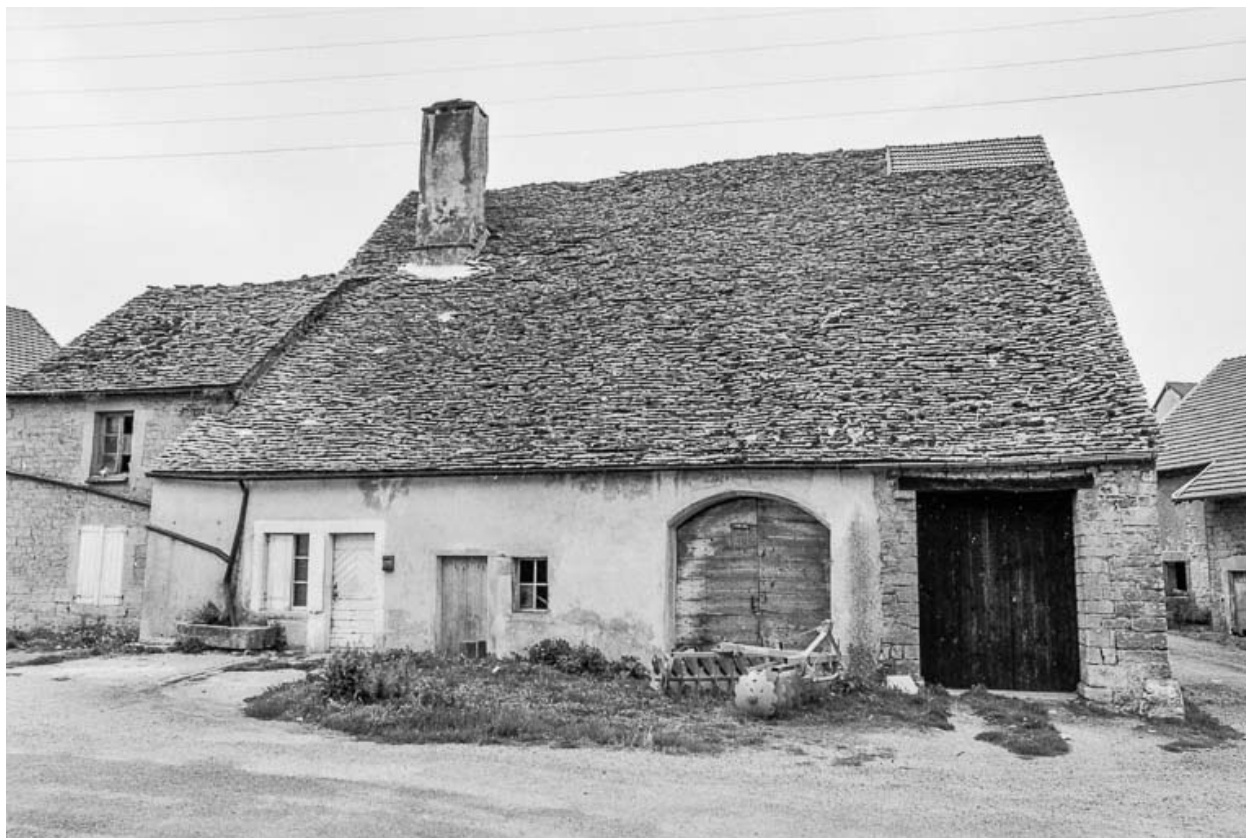
Ferme cadastrée 1951 E1 266 : façade antérieure.
