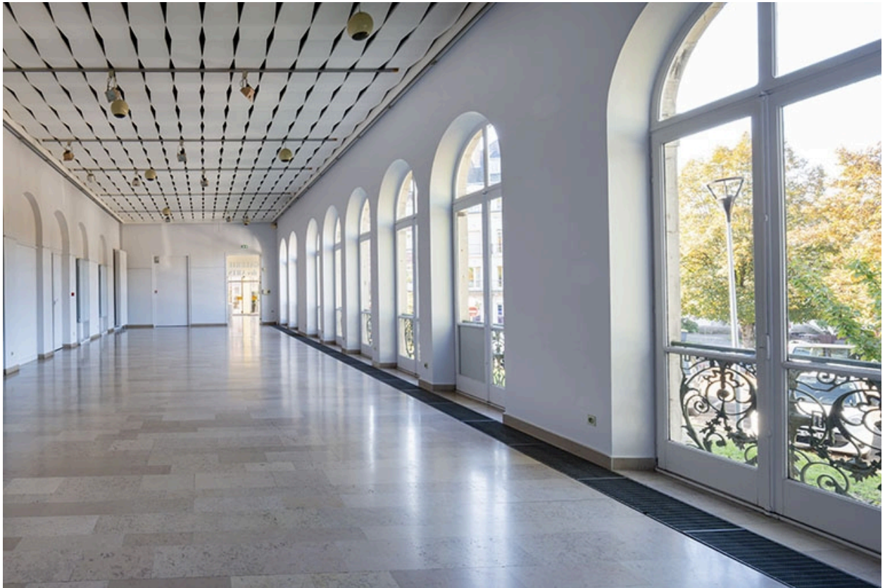
Galerie, vue en direction du sud.
