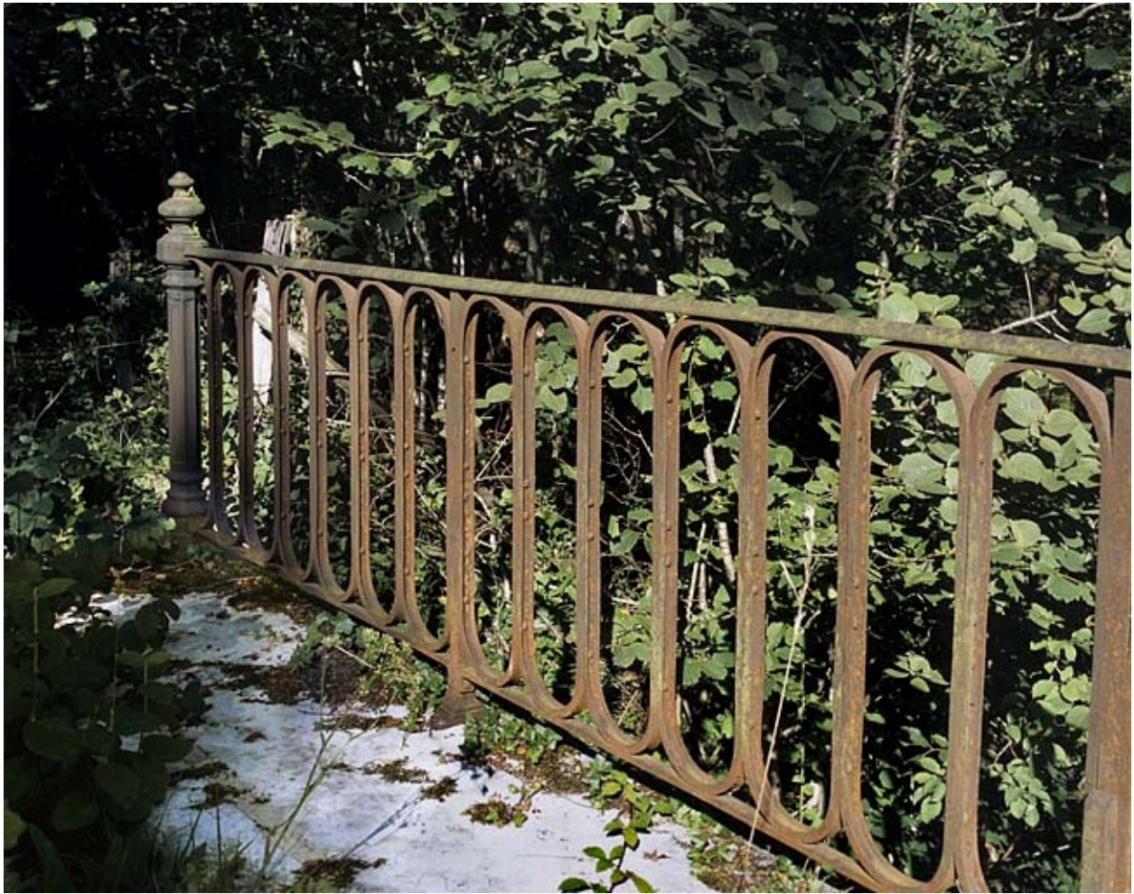
Détail d'un garde-corps.
