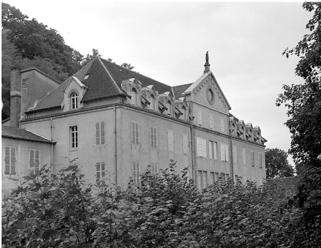
Façade antérieure du bâtiment D.
