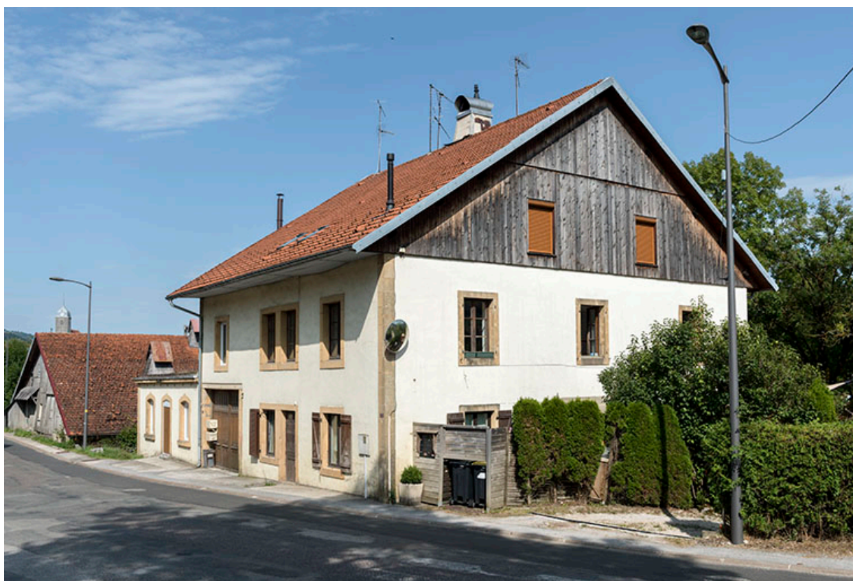
Façades antérieure et latérale droite.
