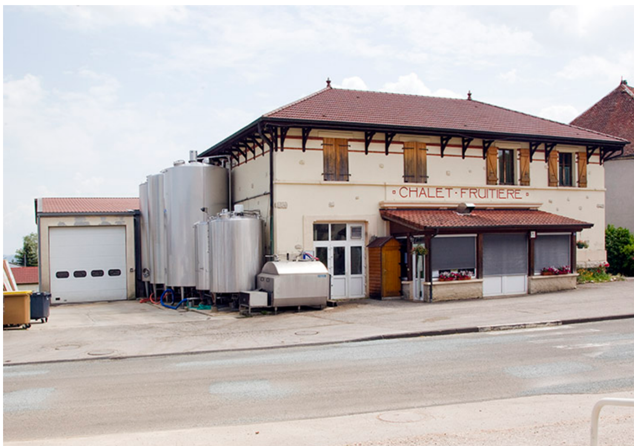
Façades antérieure et latérale gauche.
