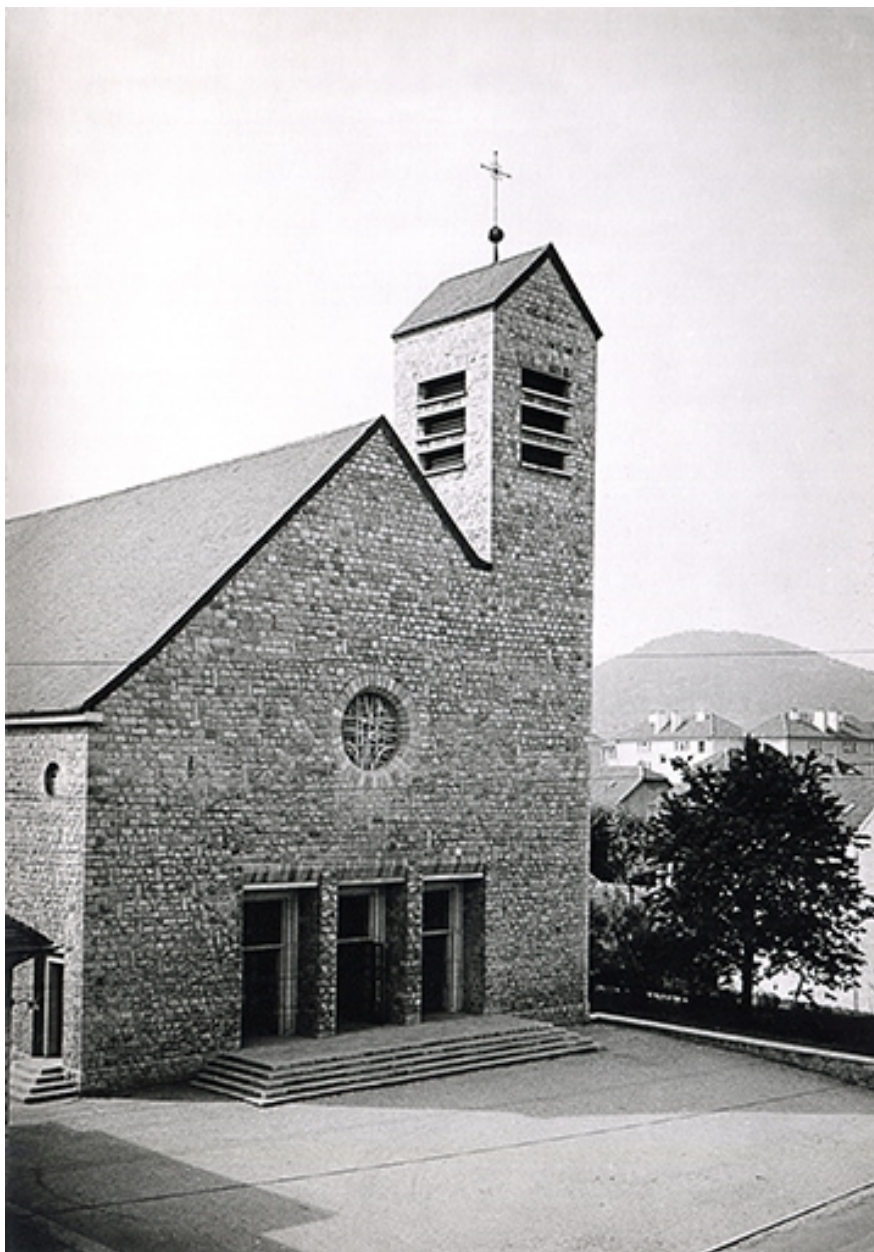
Église Saint-Joseph de Besançon, façade principale. Carte postale ancienne.
