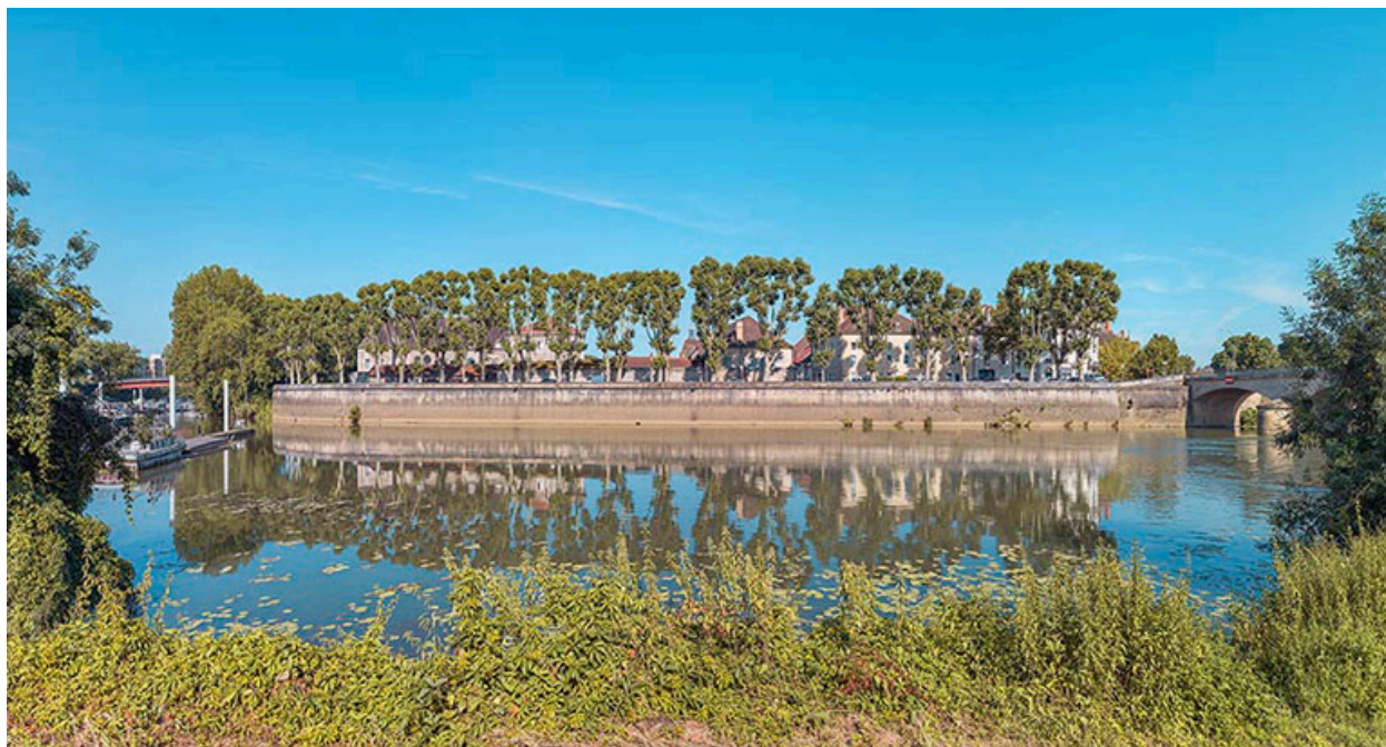
Vue générale des remparts encore en place.
