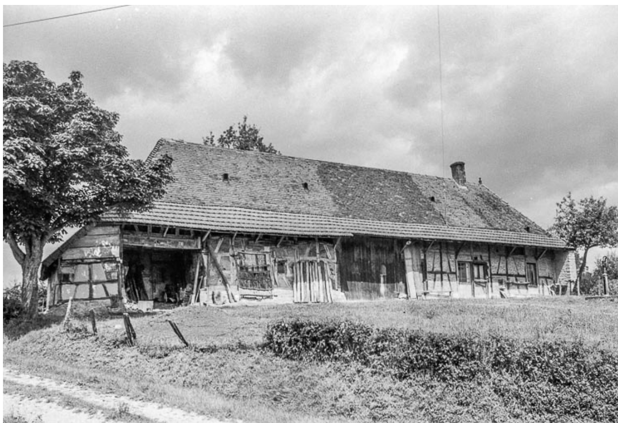
Ferme : vue générale.
