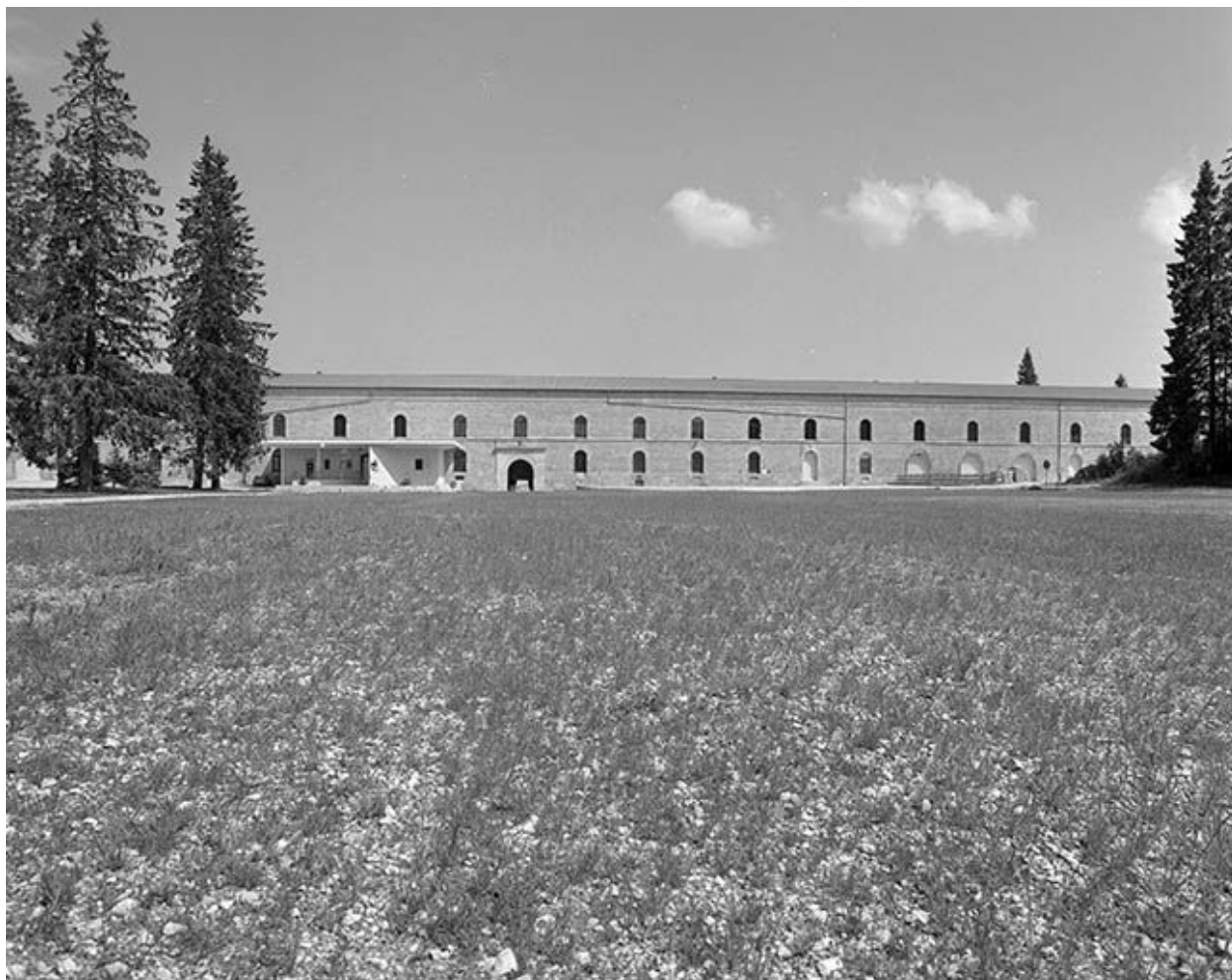
Bâtiment Cavalier, façade sur la cour d'exercice.
