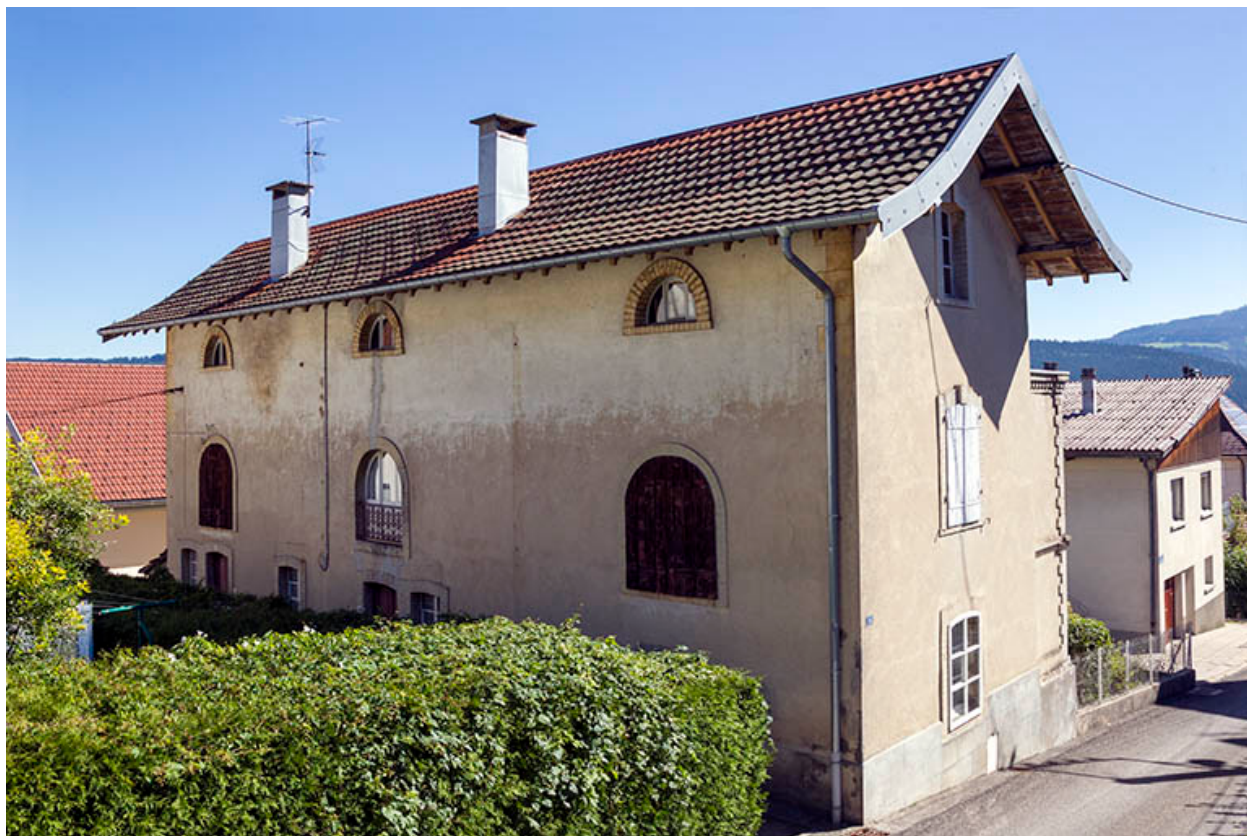
Façades postérieure et latérale gauche.
