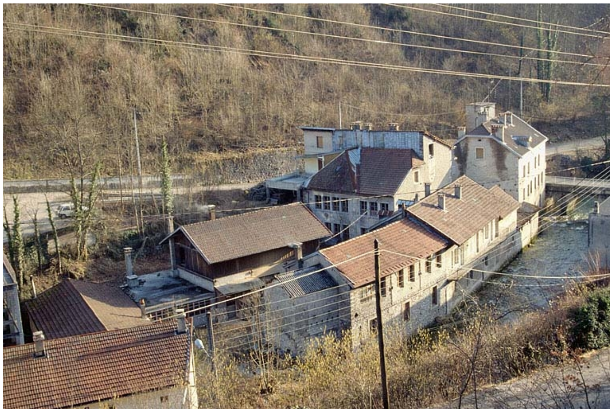
Vue d'ensemble plongeante depuis le nord-ouest.
