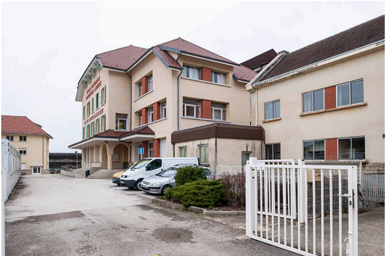
Façade antérieure ouest de l'école.
