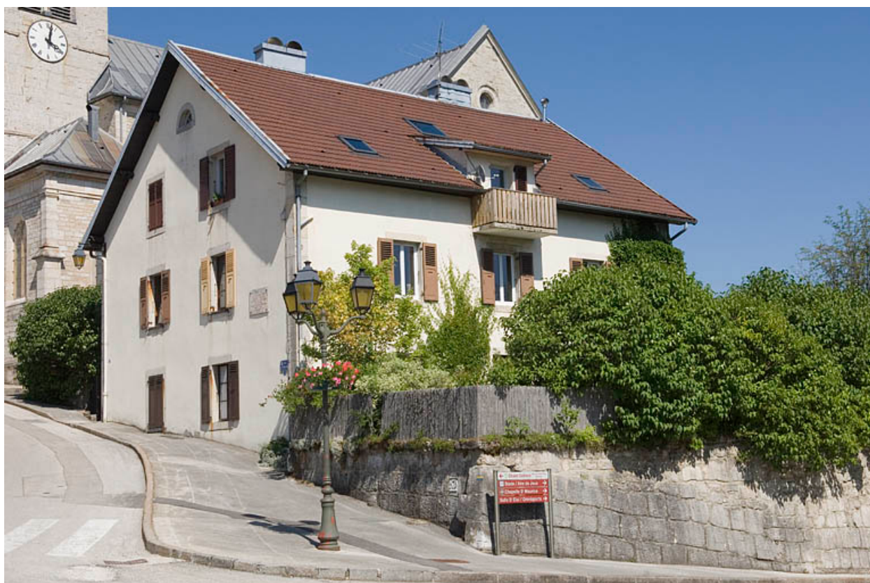
Façade postérieure et élévation droite.
