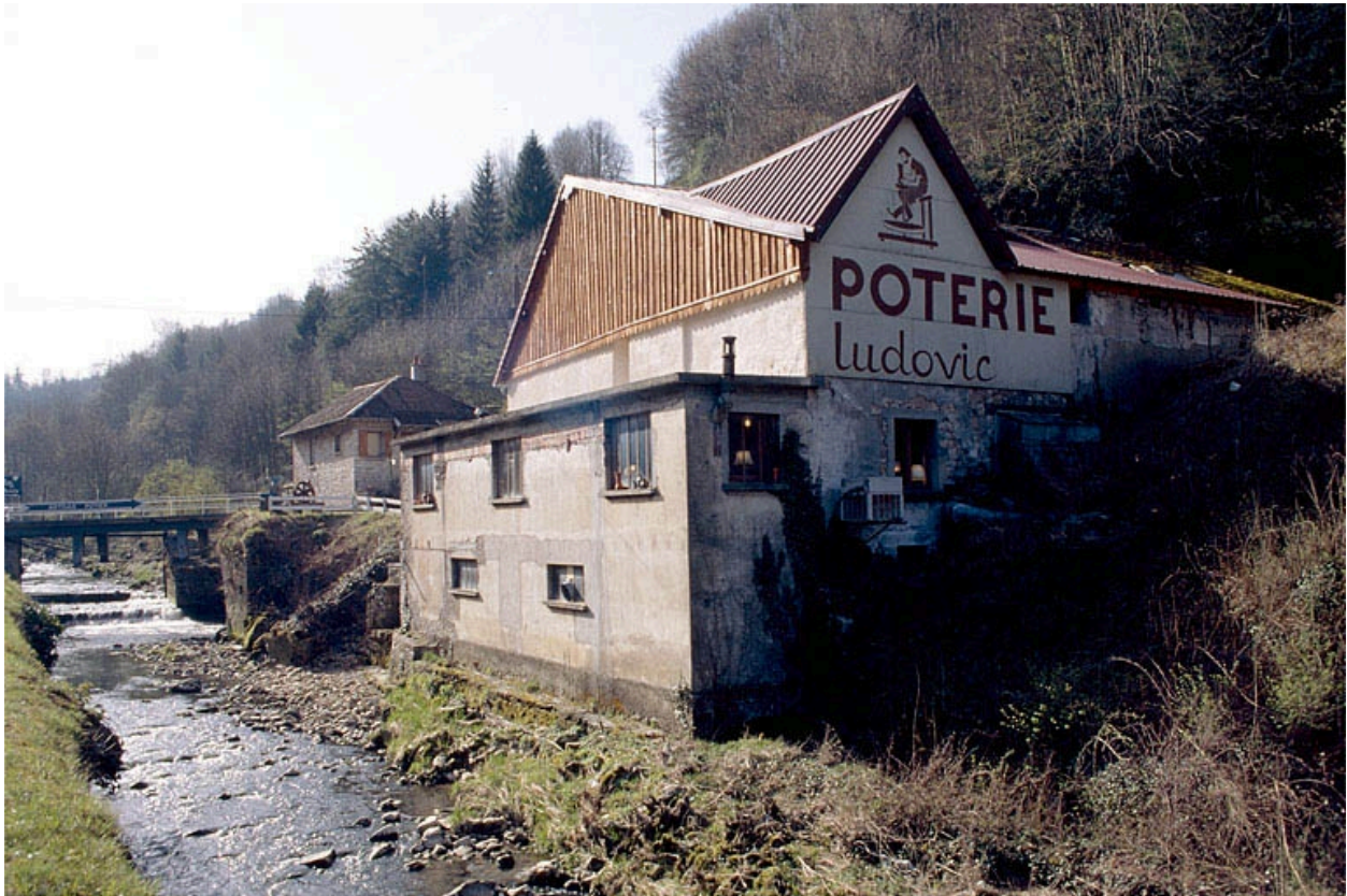
Bâtiment d'eau et atelier de fabrication.
