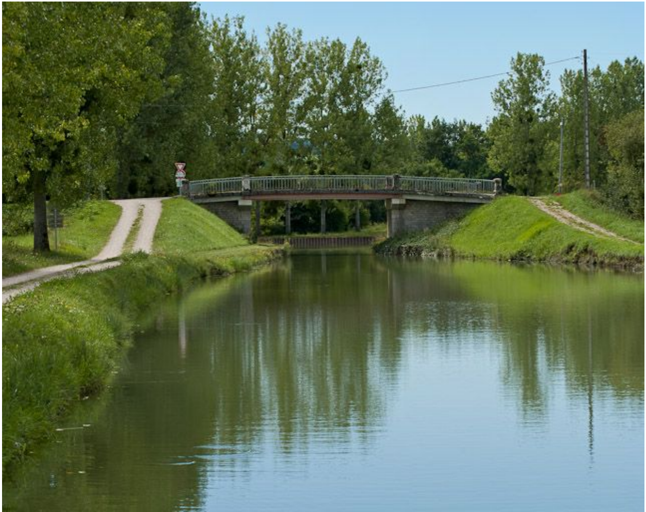
Vue du pont depuis l'amont.
