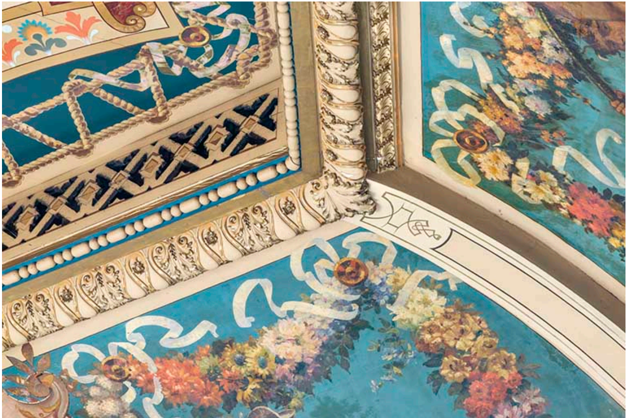
Grand Kursaal, salle : moulures au niveau de la fausse-coupole.
