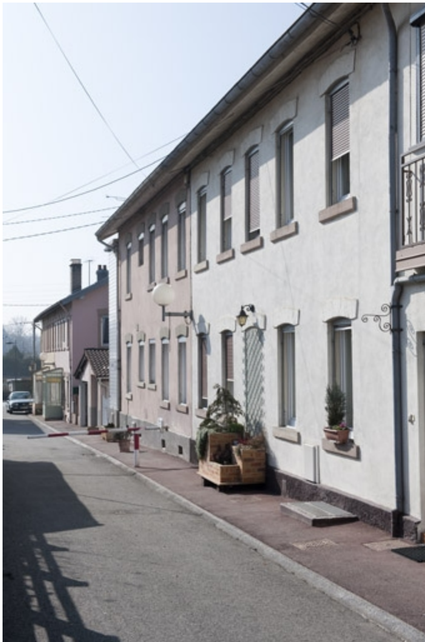
Rue des Campenottes. Habitations à 8 logements.
