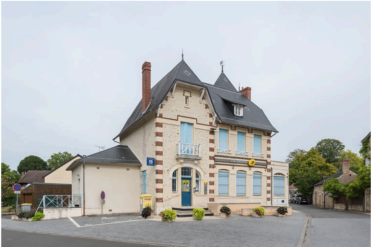
Façade, vue de trois quarts.
