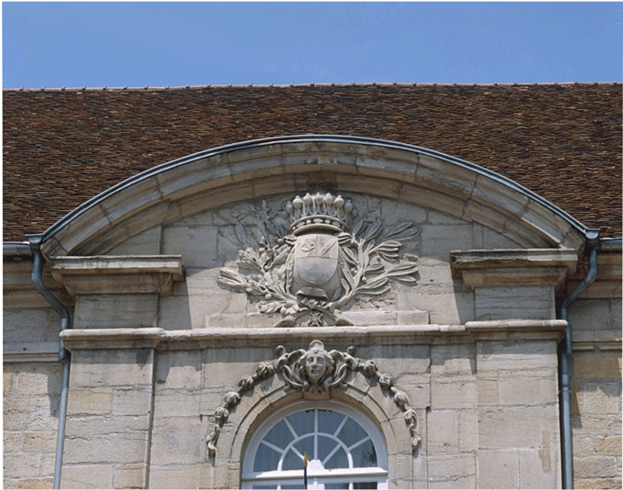
Détail du fronton de la façade sud.
