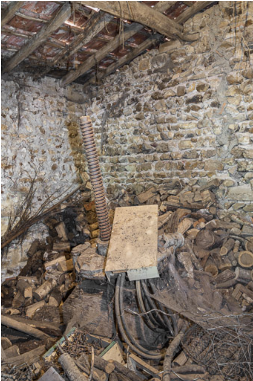
Ancien pressoir, sous l'appentis, contre la façade sud de la maison
