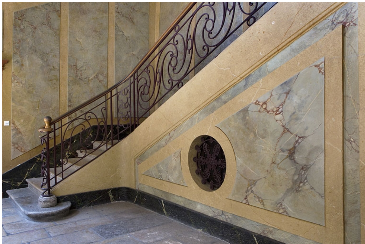
Logis principal, escalier : détail du mur d'échiffre.
