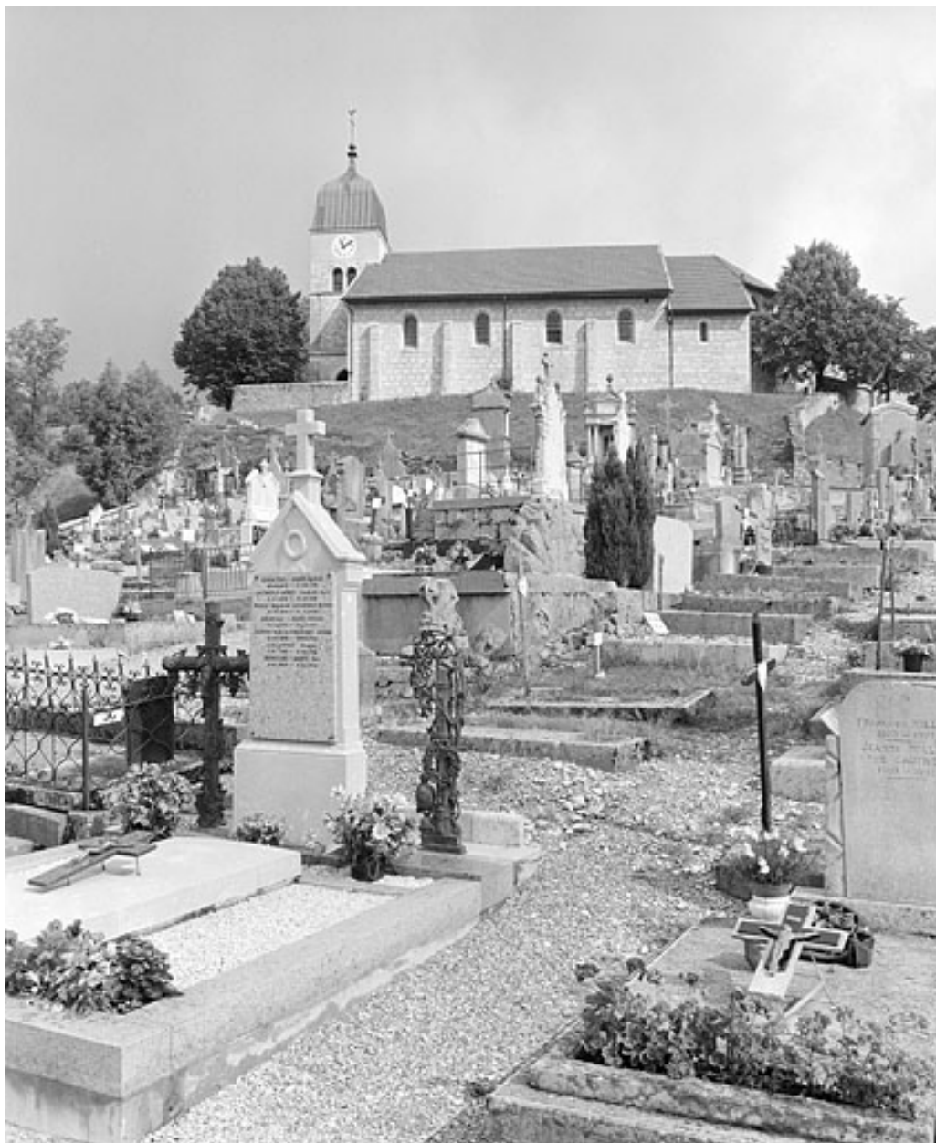
Face sud vue depuis le cimetière.
