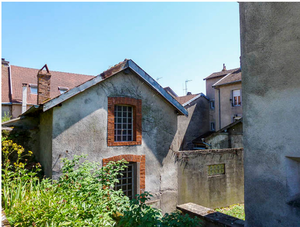
Vue générale de la remise.
